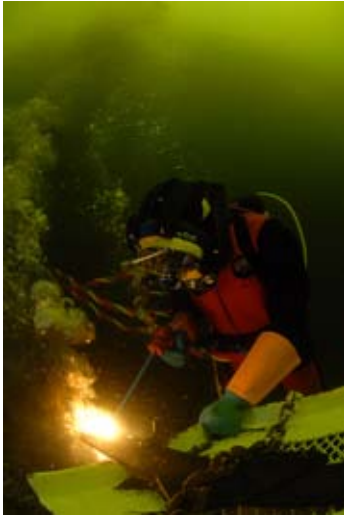
Bild 8.15. Skärning under vatten. (Foto: Försvarsmakten Joakim Tenglin)
