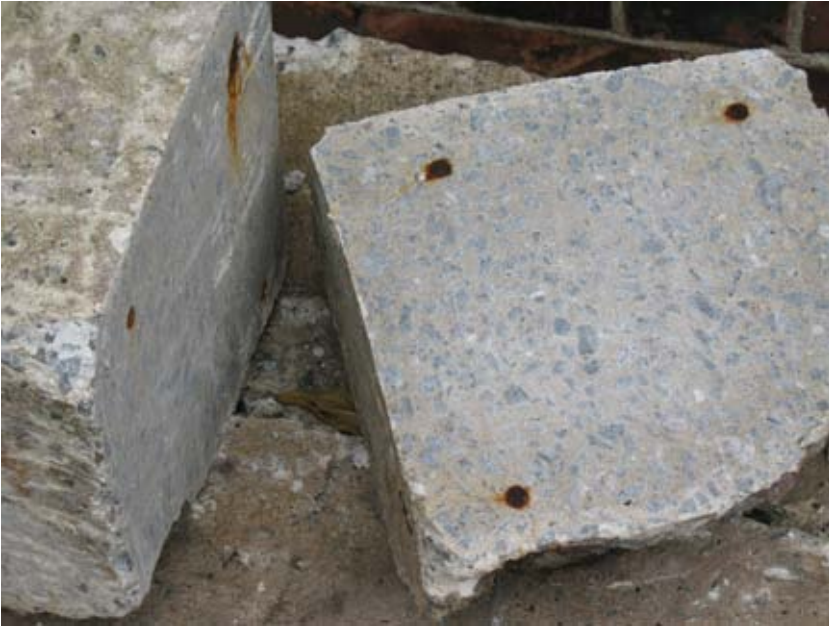
Bild 8.20. Bilden visar när man har sågat igenom en betongvikt med en hydraulsåg med diamantkedja. (Foto: Försvarmakten Michael Elsberg.)
