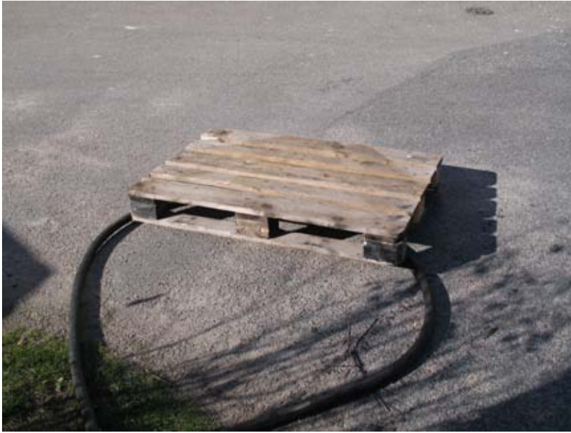
Bild 8.27. Bilden ovan har man lagt en pall över skarven för att hindra att den far upp vid ett eventuellt slangbrott och skadar någon. Ha som grundregel att alltid ha kompressorn och luftslangar borta från människor. (Foto: Försvarmakten Michael Elsberg)
