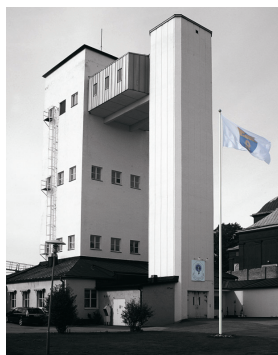
21 meter djup övningsstank för utbildning i fri uppstigning.
